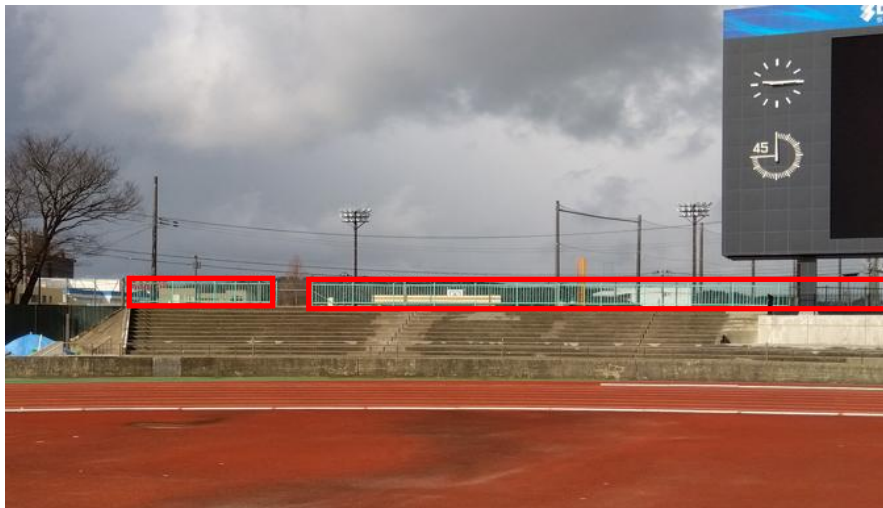
大型映像装置左側上部手すり
