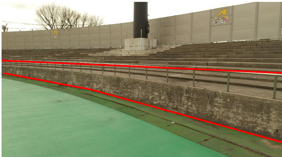
前列手すり部分(高さ約125cm)
